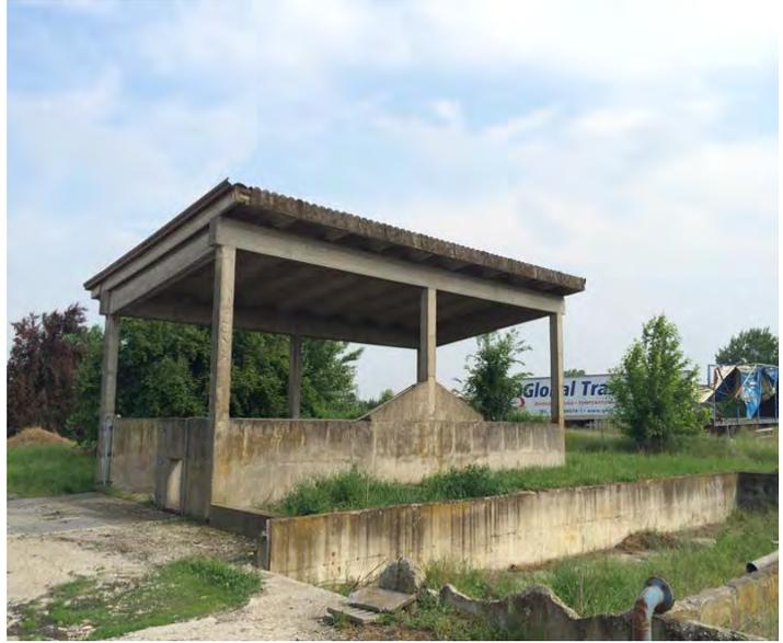
Capannone in c.a. – da demolire – copertura con fibre di cemento amianto
