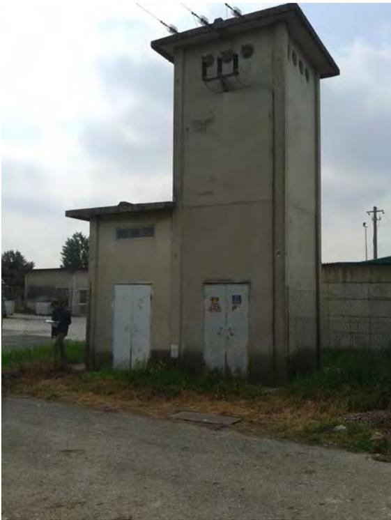
Cabina elettrica – ripristinare impermeabilizzazione
